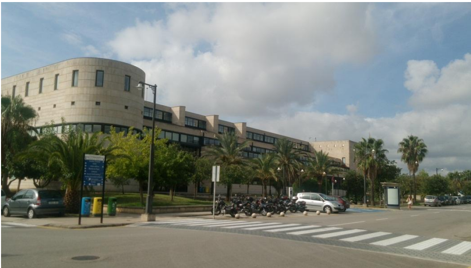
Uno de los edificios de la Universidad
